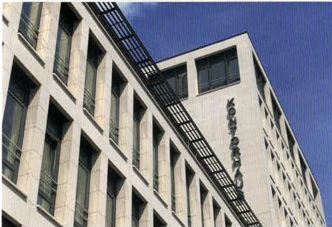
Bild links: bitlogic-Vertriebsleiter Arne Nickel (links) und Unternehmenschef Karsten Laufer arbeiten eng zusammen. Oben: Der Firmensitz befindet sich im Kontorhaus an der Frankfurter Straße. Nach der Gründung von bitlogic im Jahr 2000 wurden im Unternehmen viele Projekte erfolgreich umgesetzt. Rechts: Karsten Laufer am Traditions-Flipper, an dem möglichst bald wieder Turniere stattfinden sollen. Fotos: Claudia Taylor/oh
